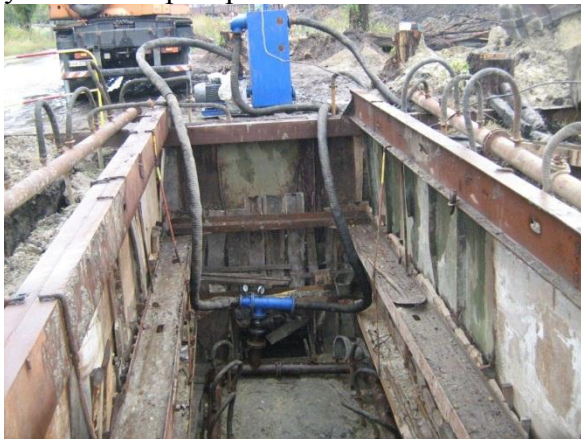
Рис.1 - Водопонижение с помощью установки ПУВВ-5МЕА при проведении ремонтно-восстановительных работ по улице Довгалевского
