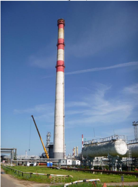
Рис. 1 - Общий вид железобетонной дымовой трубы высотой H=120\text{м} печей П-601 и П-602 технологической установки ЛЧ 35/11.
