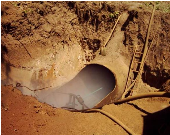
Рис. 3 - Гидродинамическая очистка под сверхвысоким давлением участка трубопровода водовода «Кочеток–Харьков» перед нанесением цементно-песчаного раствора.
