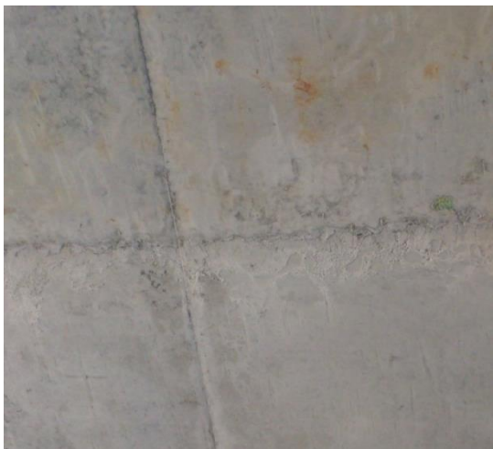
Рис. 3 - Характерные трещины в месте устройства рабочего шва плиты перекрытия после распалубливания.
