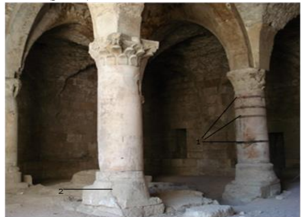
Рис.4 - Усиление колонны в Дворцовом зале цитадели Дамаска: 1 – металлические хомуты, 2 – заделка трещин.
