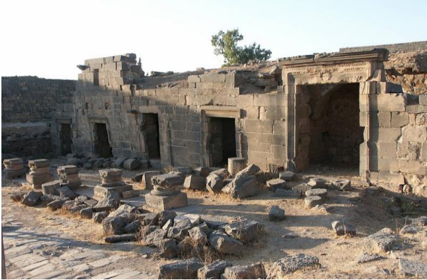
Рис.4 - Разрушение каменной кладки вследствие осадки основания (Босра)
