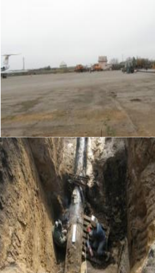
Рис.2 - Прокладка сетей водоснабжения и канализации
