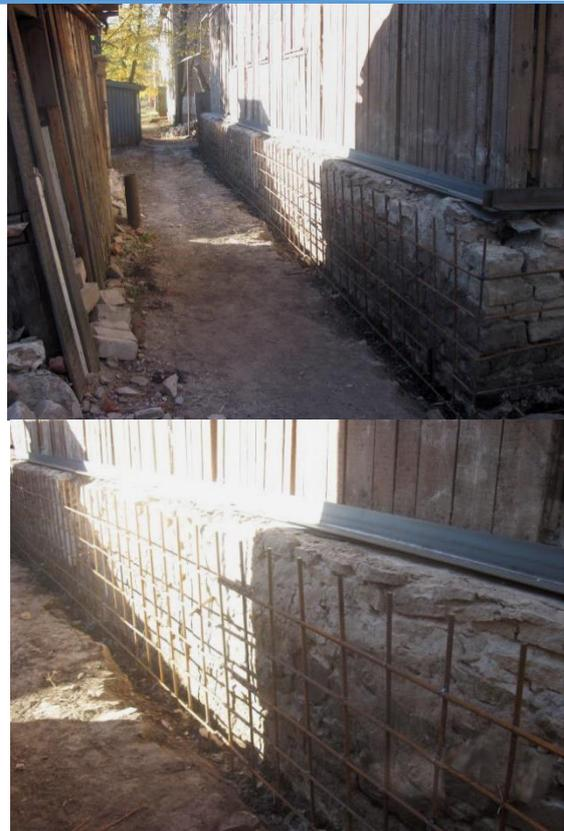
Рис. 3. Установка арматурных стержней в пробуренные шпуров и образование арматурной сетки фундаментной стены
