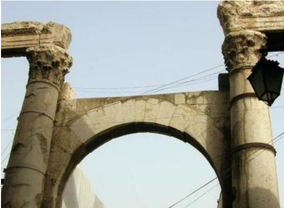
Рис.5. Усиление арок традиционным методом набетонки, а опор арки обоймами.
