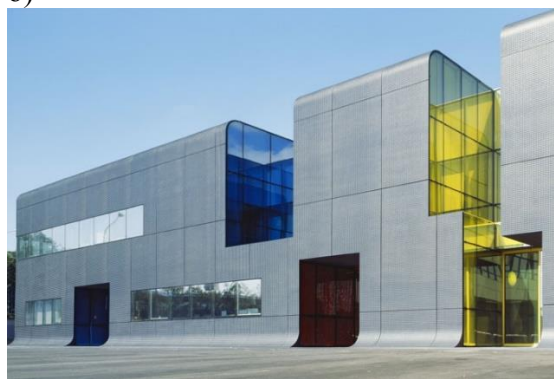
Рис.5. Фасадные панели из реакционно-порошкового бетона
