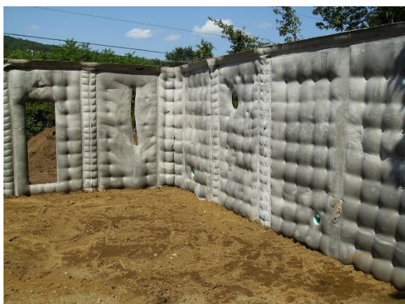
Рис. 8. Конструкция стен из бетонной ткани
