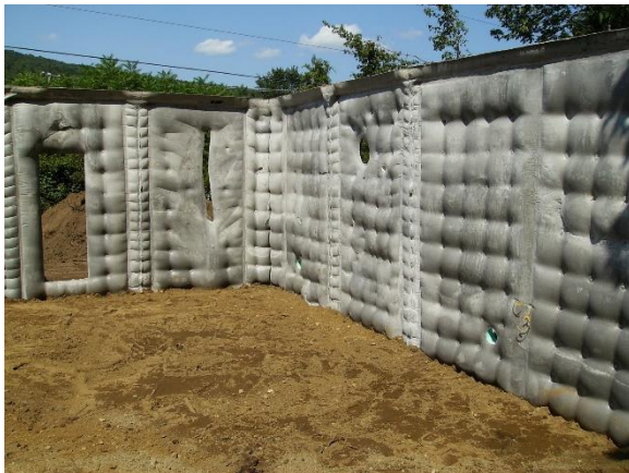
Рис. 8. Конструкция стен из бетонной ткани
