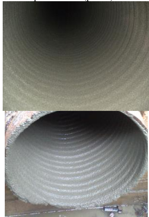
Рис. 4. Покрытие, нанесенное центробежным набрызгом
