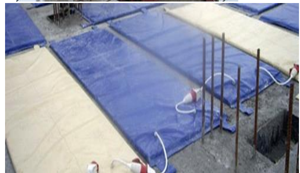
Рис.3. Фрагменты обогрева конструкций термоактивными матами [3]
