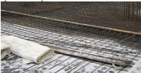
Рис. 1. Подготовка к возведению железобетонной монолитной плиты перекрытия в зимних условиях.
