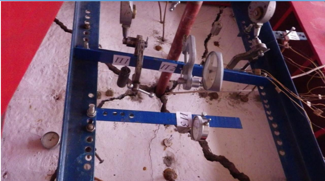
Рис.8. Разрушение плиты П1 0
