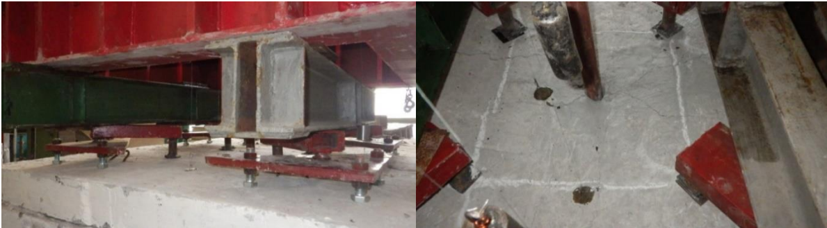
Рис.16-17. Конструкция распределительной траверсной системы на 12 точечных опор для второго пролета П2
