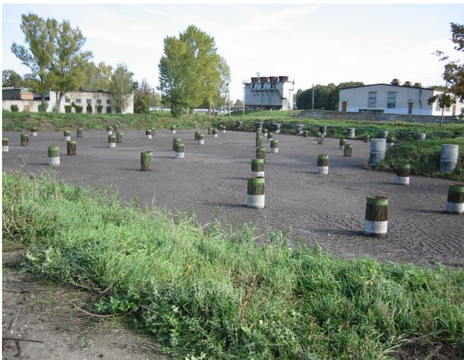
Рис. 1. Иловая площадка, оборудованная дренажной системой
