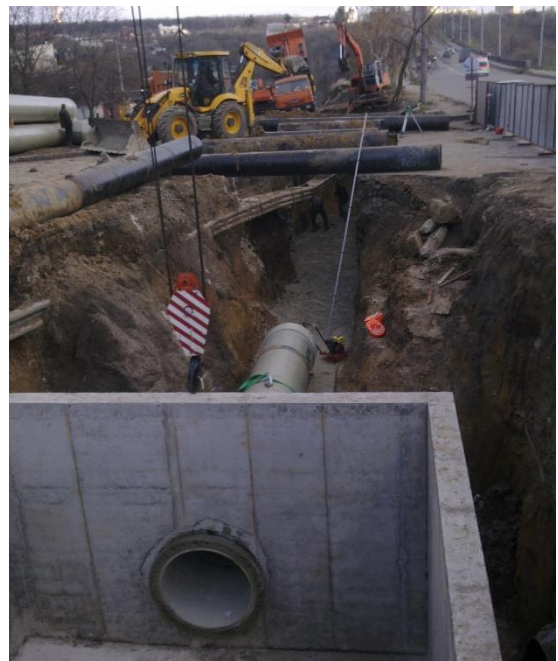
Рис. 3. Укладка водовода SUBOR DN 1000 по ул. Деревянко в г. Харькове
