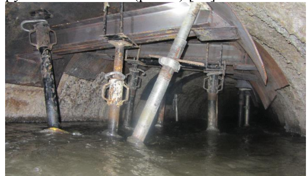
Рис. 7. Фотофиксация состояния конструкций тоннельного коллектора
