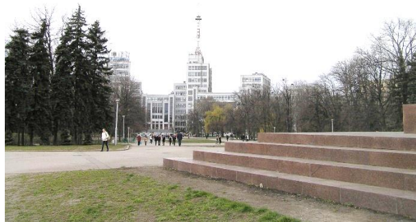
Рис. 1. Общий вид башни (радиомачты) на крыше здания Госпром.
