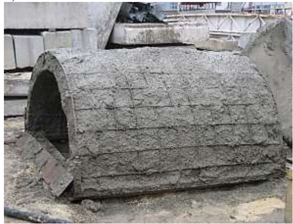
г) нанесенный первый слой торкрет-бетона на внешнюю сторону остова
