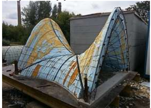
г) каркас для гипара
