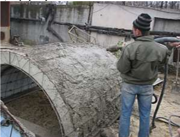
в) торкретирование внешней обшивки
