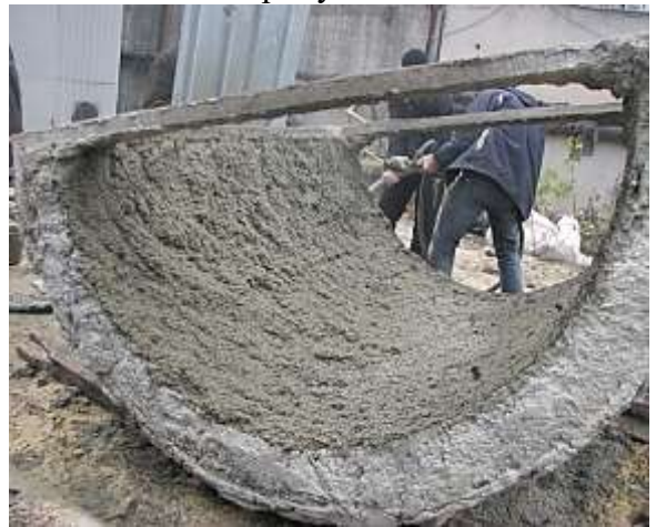
е) торкретирование внутренней обшивки
