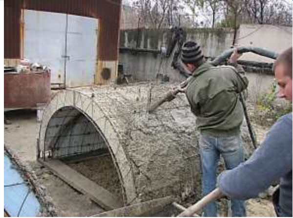
б) заполнение швов
