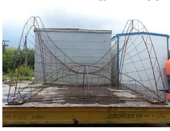
г) элементы остова для фрагмента гипара
