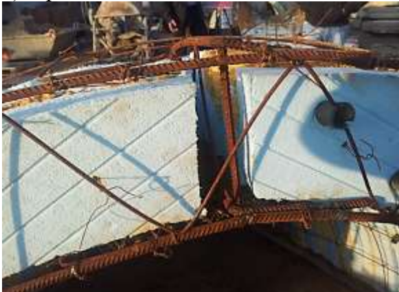
д) вид фрагмента плоского каркаса
