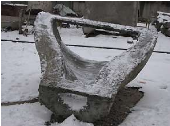
в) заторкретированный фрагмент ноцоида
