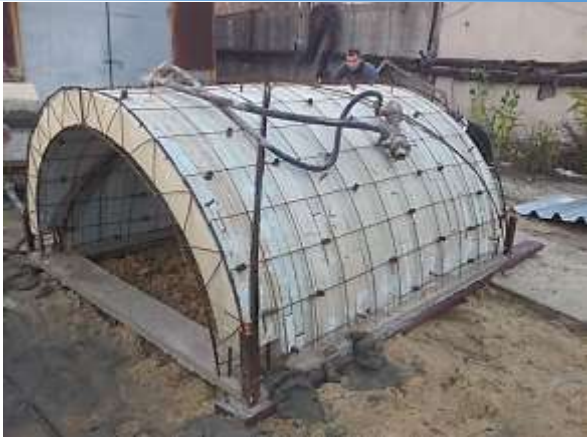
а) каркас для цилиндра
