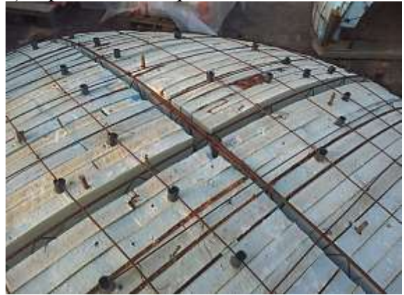
е) расположение вкладышей в самонесущем остоле
