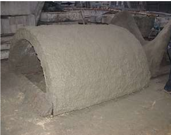
д) внешний вид торкрет-бетона перед нанесением финишного слоя
