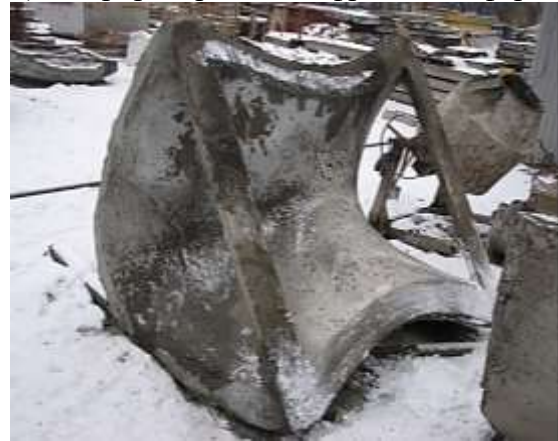
г) заторкретированный фрагмент гипара
