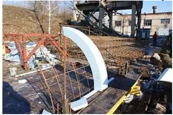
е) процесс установки неизвлекаемых вкладышей-пустотообразователей в остова
