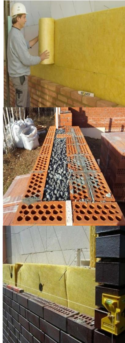
**Рис. 5.** Устройство утеплителя
