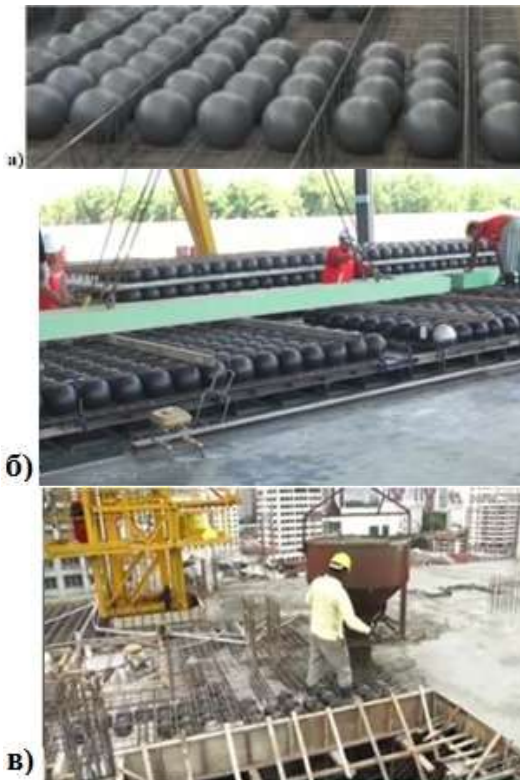
Рис. 5. Устрійство об'легчених залізобетонних перекриттів по технології BubbleDeck: а) виготовлення блоку з вкладышей з арматурою; б) установка блоку вкладышей в арматуре на нижню обшивку; в) добетонування верхньої обшивки
