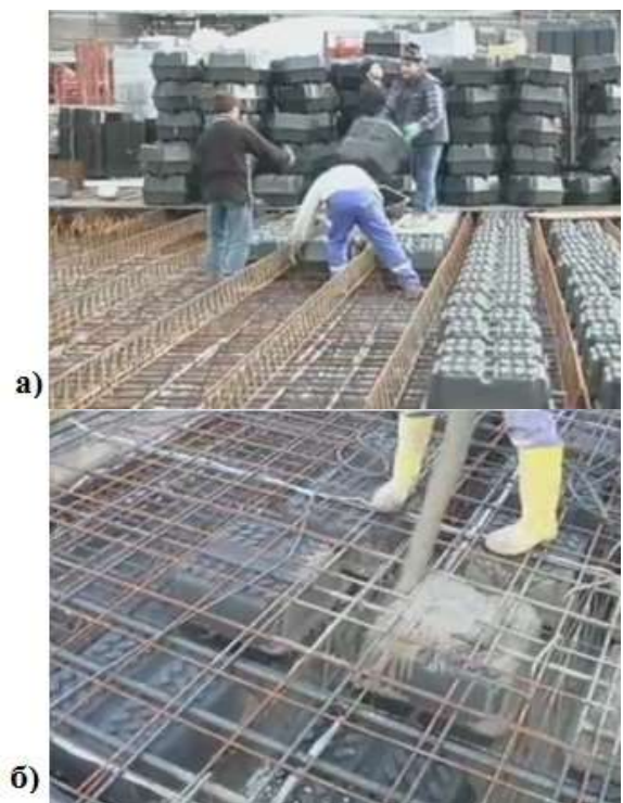
Рис. 10. Устройство облегченных железобетонных перекрытий по системе U-Boot Beton: а) установка вкладышей-пустотообразователей; б) бетонирование плиты
