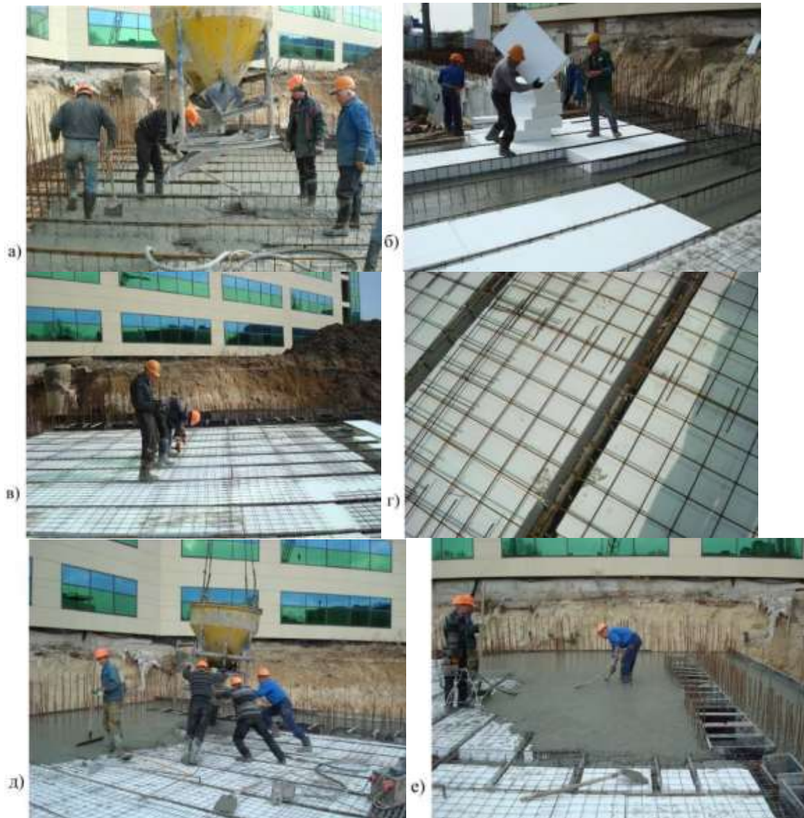
Рис. 15. Устройство облегченного железобетонного перекрытия: а) бетонирование нижней обшивки перекрытия; б) установка вкладышей из пенополистирола; в) монтаж верхней арматурной сетки; г) вид перекрытия до начала второй стадии бетонирования; д) укладка бетонной смеси; е) уплотнение уложенной бетонной смеси
