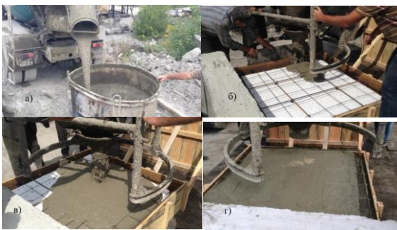
Рис. 4. Бетонирование горизонтального элемента облегченной конструкции: а) – выгрузка самоуплотняющейся бетонной смеси в бадью; б) – укладка бетонной смеси для формирования нижней обшивки плиты под вкладышем; в) – укладка бетонной смеси для формирования ребер и верхней обшивки плиты; г) – всплытие арматурного каркаса вместе с вкладышем
