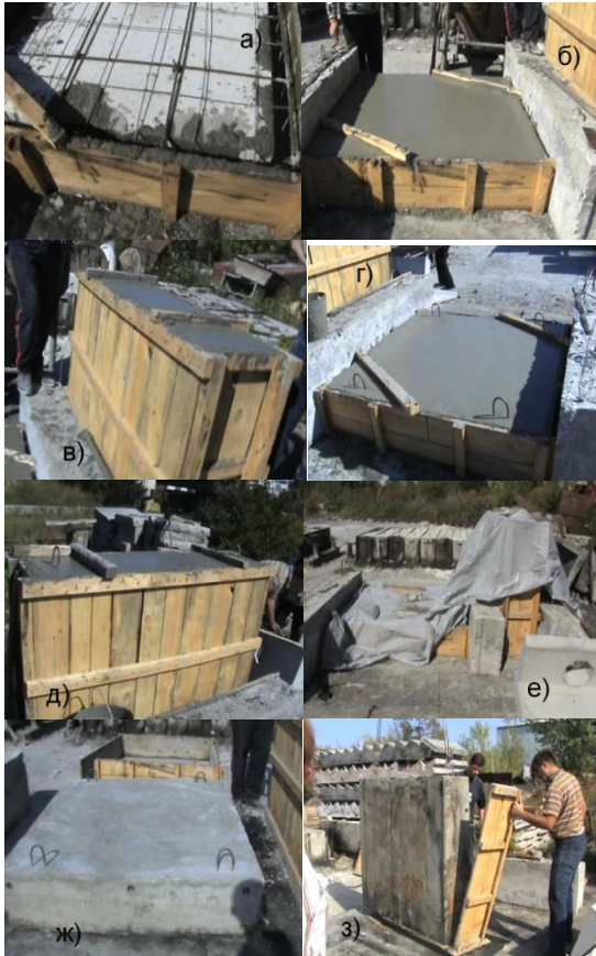
Рис. 6. Бетонирование облегченных конструкций с применением СУБ в одну стадию в два слоя: а) – укладка первого слоя бетонной смеси под вкладыши; б) – укладка второго слоя для горизонтального элемента; в) – укладка второго слоя для вертикального элемента; г) – установка монтажных петель для горизонтального элемента; д) – установка монтажных петель для вертикального элемента; е) – укрытие пленкой забетонированных конструкций для набора прочности бетоном; ж) – распалубка горизонтального элемента; з) – распалубка вертикального элемента
