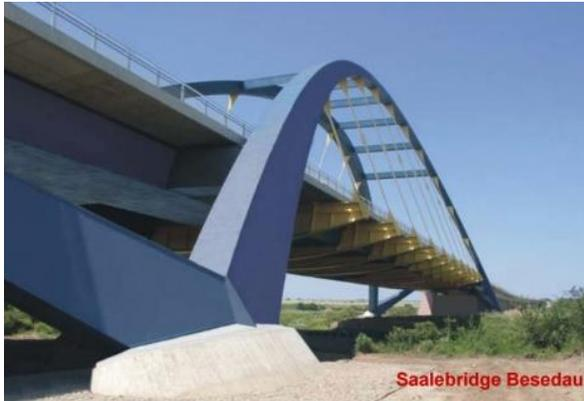
Рис. 5. Сталежелезобетонная арка с затяжкой [1]
