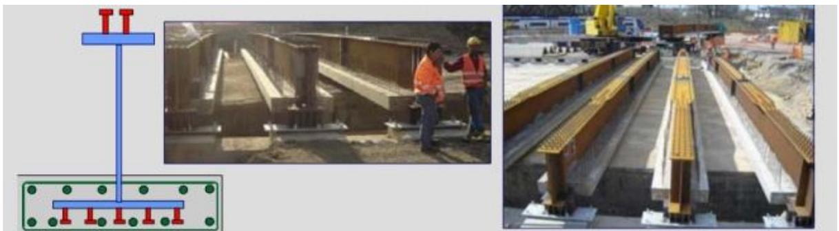
Рис 10. Сталежелезобетонные пролетные строения с применением prefle-балки [1]
