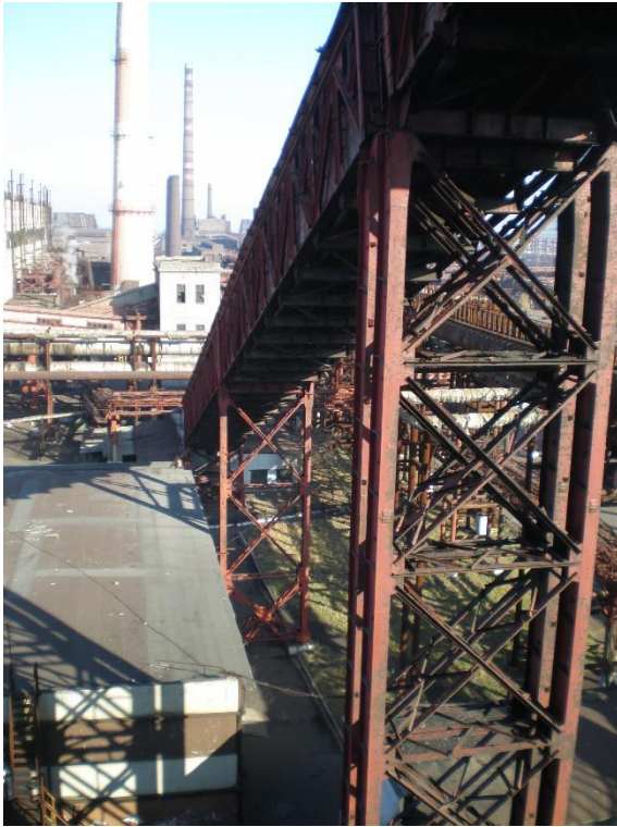
Фото 1. Общий вид транспортерной галереи.
