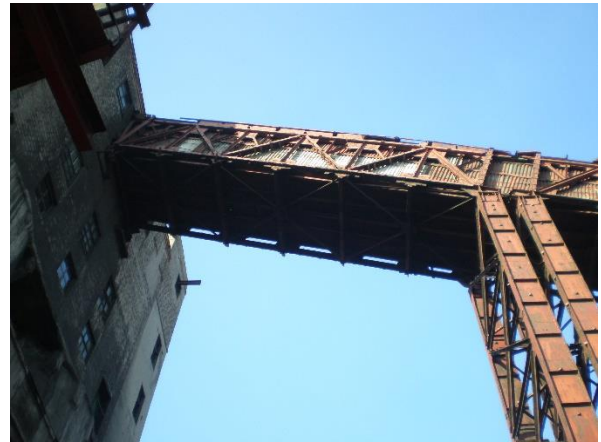
Фото 2. Металлические фермы верхнего пролета.
