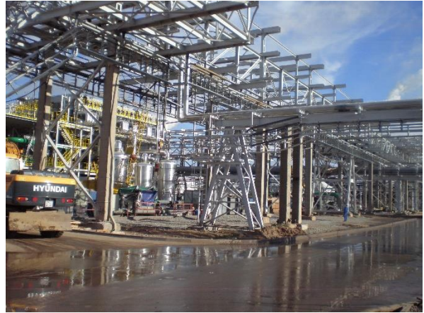
Фото 1. Общий вид эстакады 6-7 цеха Аммиак 4.
