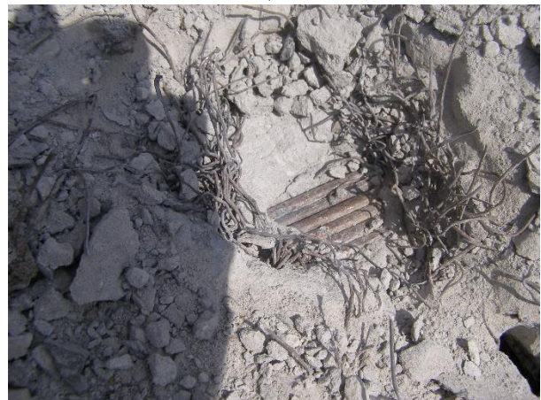
Рис. 7. Участок вскрытия кровли № 5. Несущие ванты покрытия
