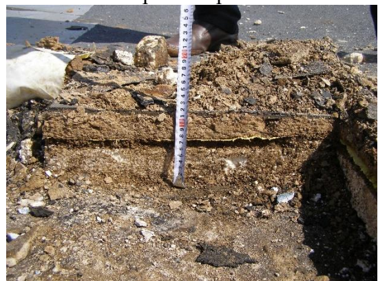
Рис. 4. Участок вскрытия кровли № 3. Состав кровельного пирога
