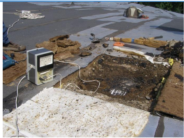
Рис. 6. Определение положения несущих вант с помощью ИЗС-10Н
