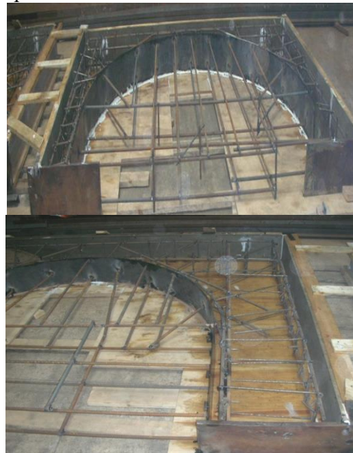
Рис.1 Армирование: фрагмента №1- с футеровкой и №2 - без футеровки
