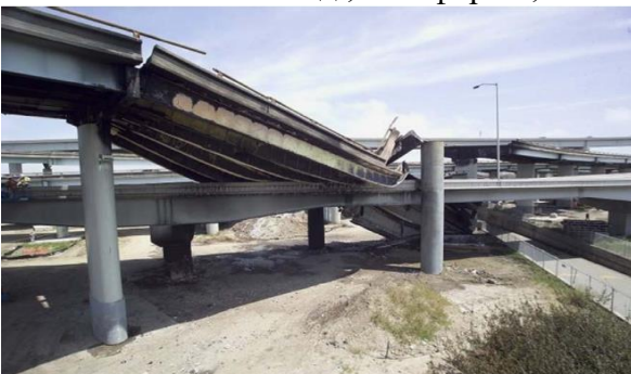
Рис. 5. Наслідки пожежі на розв'язці MacArthur Maze в Окленді, Каліфорнія, 2007
