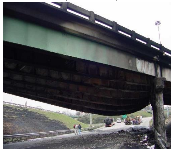
Рис.3 Наслідки пожежі на пересіченні I – 65 і I – 20 – 159, Бірмінгем, Алабама, 2002
