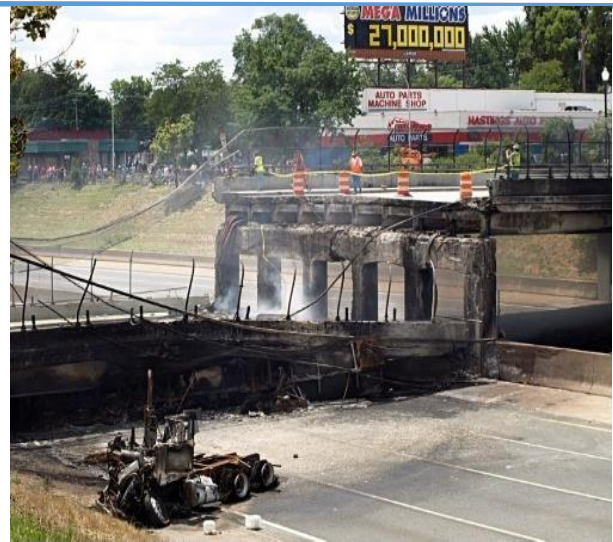
Рис. 1. Наслідки пожежі на пересіченні Hazel Park в штаті Мічиган, 2009
