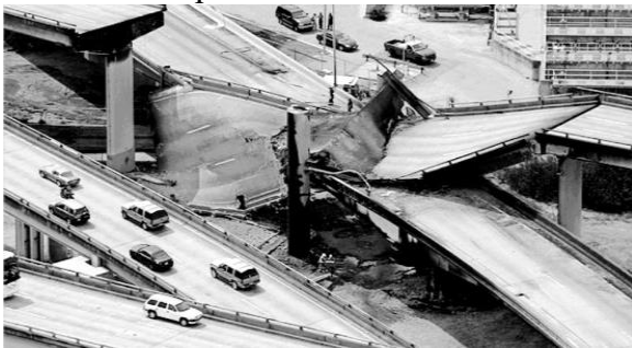
Рис. 4. Наслідки пожежі на розв'язці MacArthur Maze в Окленді, Каліфорнія, 2007
