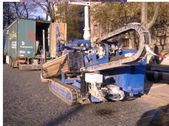
Рис. 3. Прокладка полиэтиленовых водопроводных труб DN 400 в г. Харькове методом горизонтального бурения.
