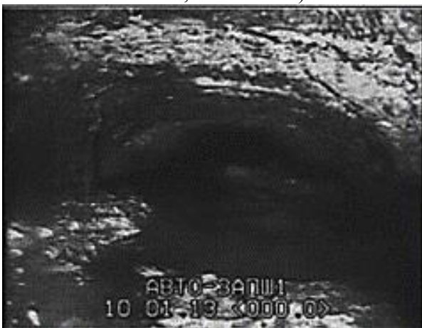
Рис. 5. Канализационный тоннель завода «Автозапчасть», шахта № 1.
