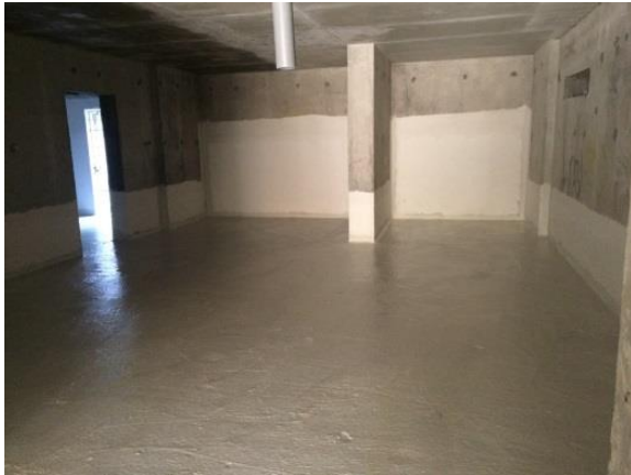
Рис. 1. Гидроизоляция подземных частей здания.
