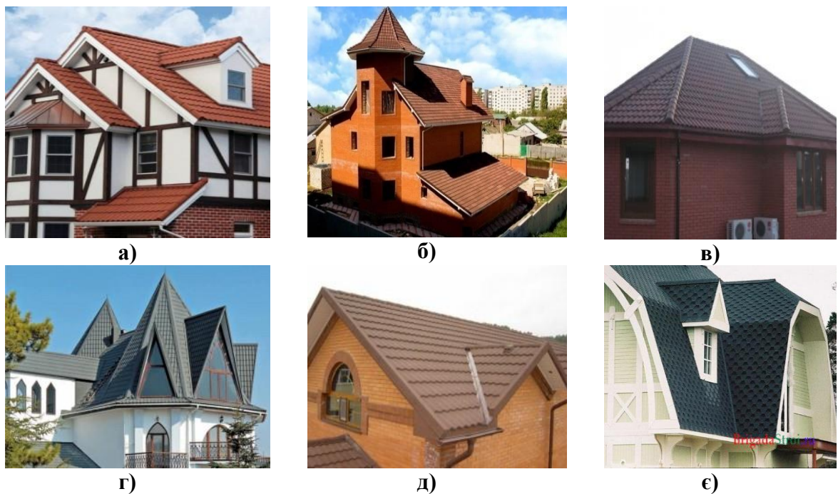
Рис.2. Загальний вигляд покрівлі з черепиці: а) керамічної; б) цементно-піщаної; в) полімерпіщаної; г) металочерепиці; д) композитної металочерепиці; е) бітумної
