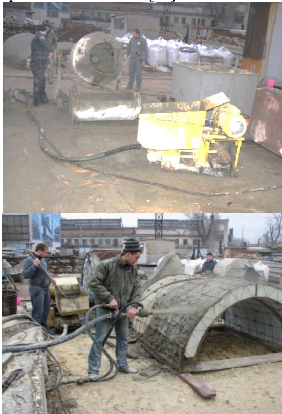
Рис. 1. Растворобетононасос на строительной площадке и процесс торкретирования
