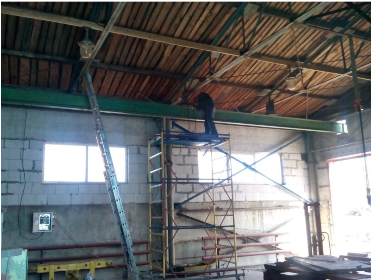
Рис.3. Монтаж конструкції балки кранового путі.
