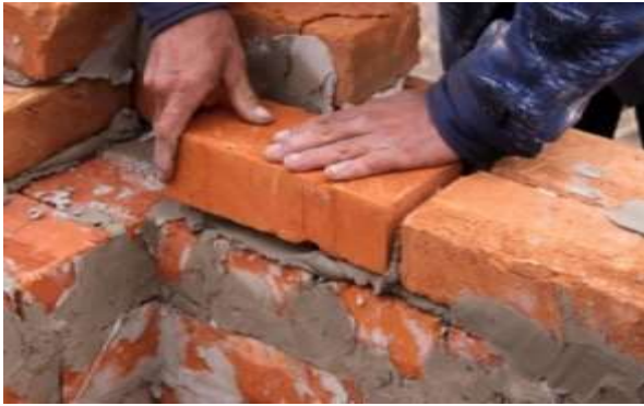
Рис. 6. Перекладка отдельных участков стен.
