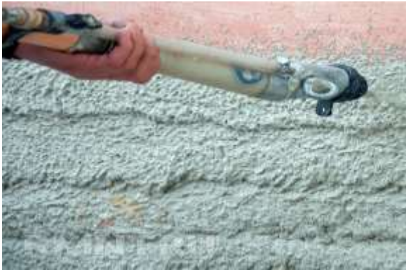
Рис. 2. Усиление стен торкретированием.
