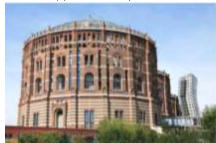
Рис. 1. Комплекс зданий газгольдеров в Вене, 1896 – 1899 гг. Высота – 70 м.
