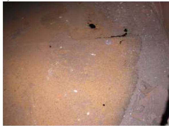
Рис. 2. Коррозионные повреждения дымовой трубы: а) – коррозионный износ ствола до 20% сечения; б) сквозная коррозия днища трубы.
