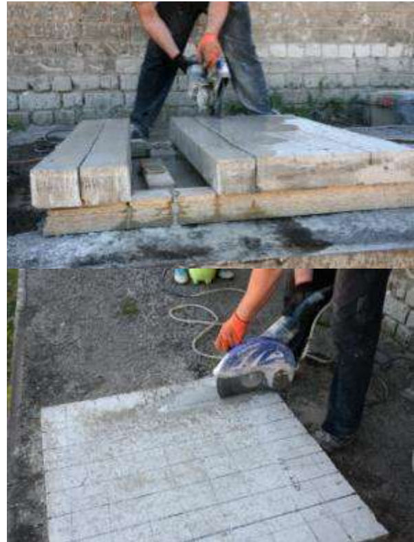
Рис. 4. Разрезка плит на балки
