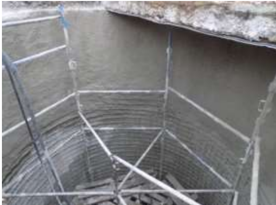
Рис.19. Усиление стены шахты №10 канализационного туннельного коллектора 761-го микрорайона в г. Харькове торкретбетонным покрытием армированным стеклокомпозитными сетками
