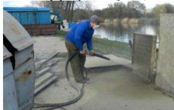
Рис.2. Изготовление опытных образцов плит методом торкретирования
