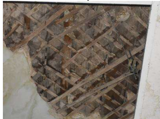
Рис. 12. Обрушение штукатурки
