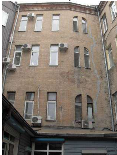
Рис. 8. Вертикальные трещины
