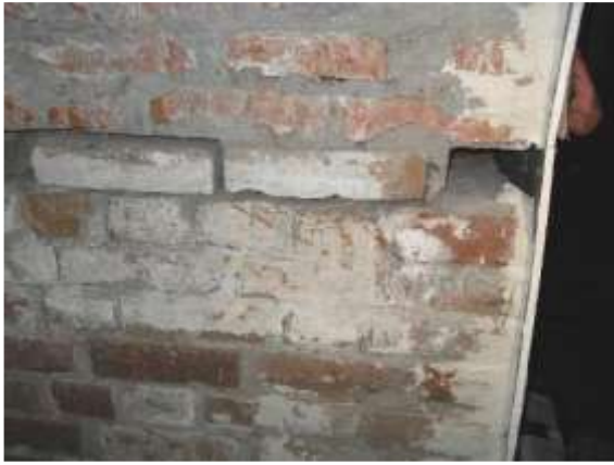
Рис. 4. Разрушение кладки
