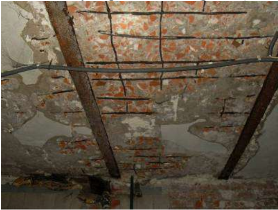
Рис. 9. Разрушение перекрытия
