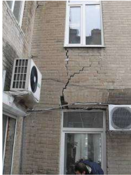
Рис. 7. Выпадение кирпича
