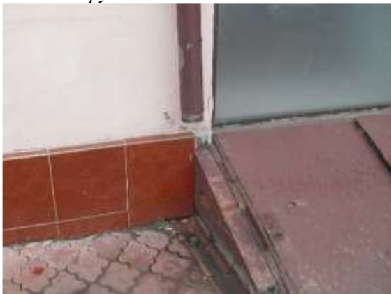
Рис. 6. Нарушение водоотвода
