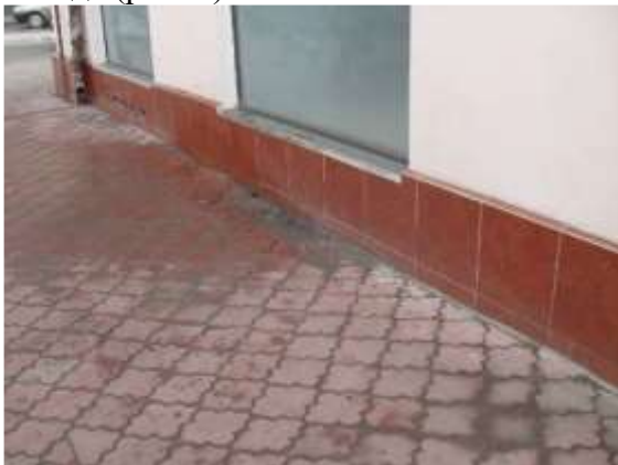
Рис. 5. Нарушение отстоки
