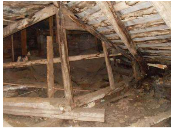
Рис. 11. Загнивание покрытия
