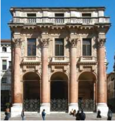
Рис. 10. Лоджия дель Капитанио в Венеции. Арх. А. Палладио. «Триумфальный» характер здания объясняется совпадением его строительства с крупной победой венецианцев над турками при Лепанто в 1571 г.
