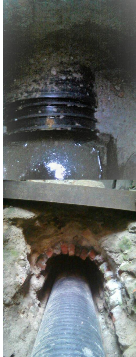
Рис. 3. Восстановление поврежденного участка коллектора
