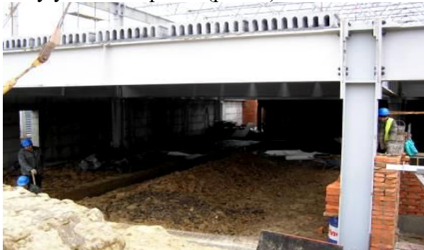
Рис. 6. Впровадження сталезалізобетонного диску у будівництво
