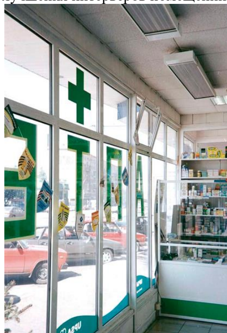
Рис. 1. Отопление помещения аптеки с помощью инфракрасных потолочных электрических панельных длинноволновых обогревателей
