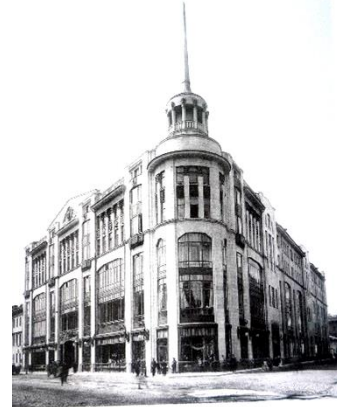
Рис. 9. Здание торгового дома Гвардейского экономического сообщества. Арх. Э.Ф. Виррих, И.В. Падлевский, С.С. Кричинский, Н.В. Васильев, Б.Я. Боткин, инж. Н.А. Белелюбский, Н.А. Житкевич, В.П. Стаценко, В.А. Шевалев
