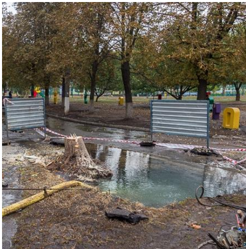
Рис. 9. Наслідки пошкодження стикового з'єднання сталевих водоводів по вул. Гвардійців Широніців (м. Харків, вересень 2017 р.)
