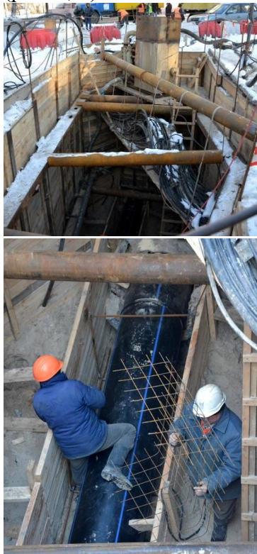
Рис. 6. Санація зношеного залізобетонного колектору поліетиленовими трубами
