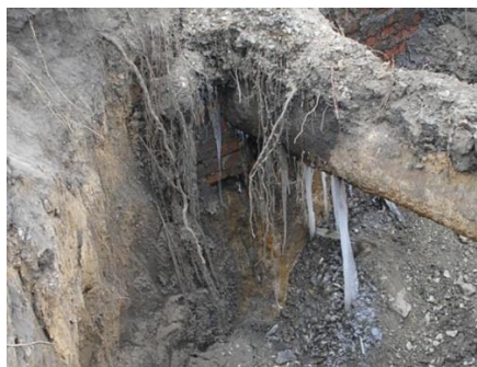
Рис. 7. Провал ґрунтового масиву (м. Прилуки, січень 2018 р.)
