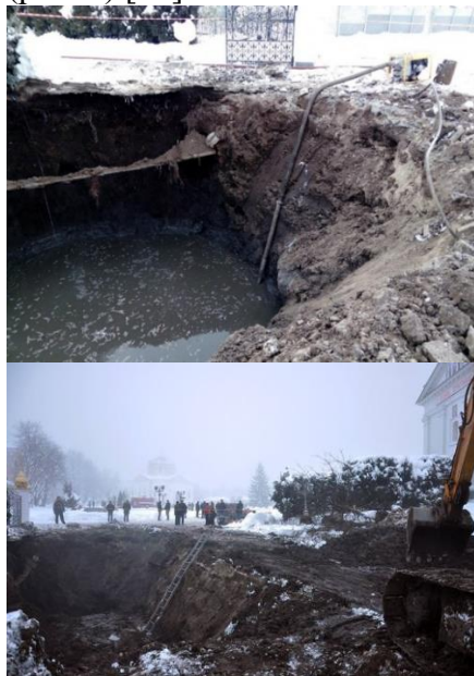
Рис. 7. Провал ґрунтового масиву (м. Прилуки, січень 2018 р.)
