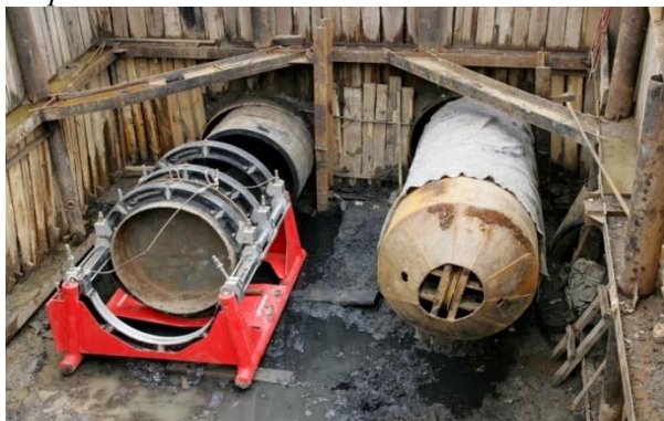
Рис. 5. Комбинированные трубы – «вкладыши»
