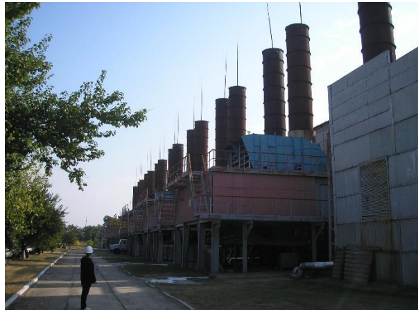
Рис. 1. Металлические дымовые трубы высотой 22.00м компрессорной станции «Кировоградская» магистрального газопровода.
