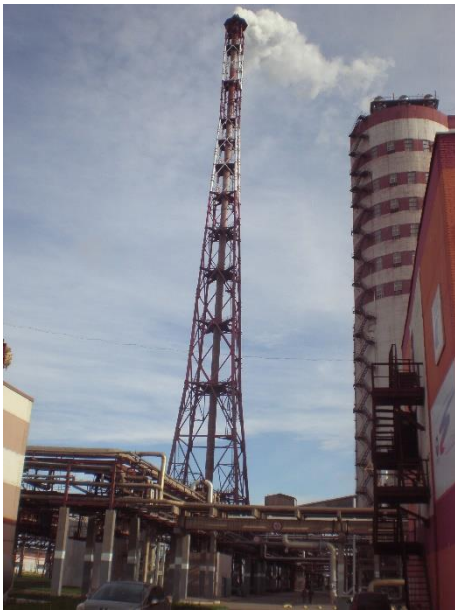
Рис. 2. Общий вид металлической башни высотой 180м цеха Аммиак ОАО «Акрон», г. В. Новгород
