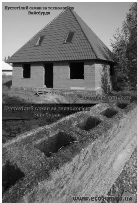
Рис. 2. Будинок з пустотілого саману у м. Радомишль Житомирської області побудований у 2012 р.
