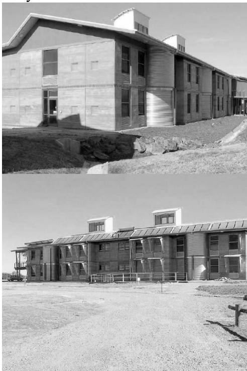
Рис. 4. Житлова будівля у Чарльз Стюартському університеті у Австралії з стінами з монолітного глинобетону [9]
