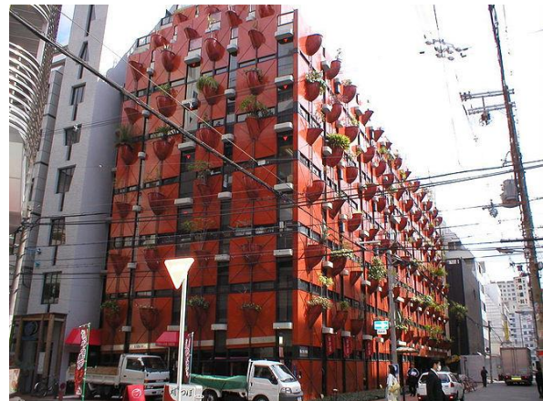
Рис. 8. Гаэтано Пэше. Здание Organic Building в Осаке
