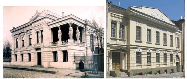
Рис. 13. Бывшие особняки архитектора А.Н. Бекетова в Харькове на ул. Совнаркомовской №№ 9, 37, 1902 – 1913 гг.
