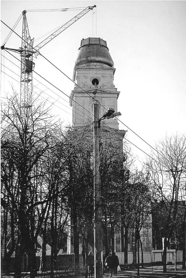
Рис. 8. Монтаж елементів шпиль дзвіниці
