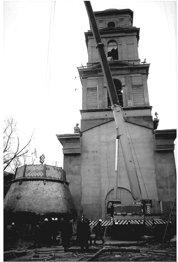
Рис. 7. Монтаж нижнього елемента шпилью дзвіниці
