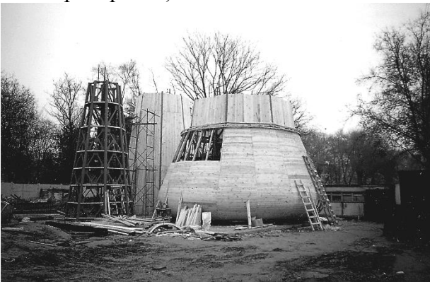
Рис. 5. Елементи шпिला обшиваються деревом і покриваються міддю на землі
